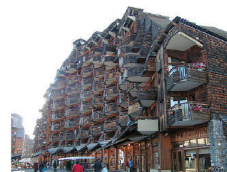
IMMEUBLE LE DOUCHKA
