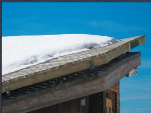
Exemple de porte-neige Immeuble "Le Snow" à Avoriaz
