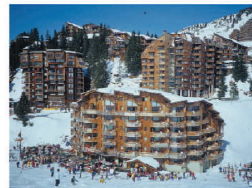
IMMEUBLE LE SÉPIA ET SES DÉTAILS
